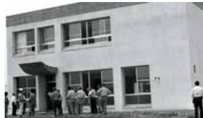
昭和44年に建設された有線放送会館
